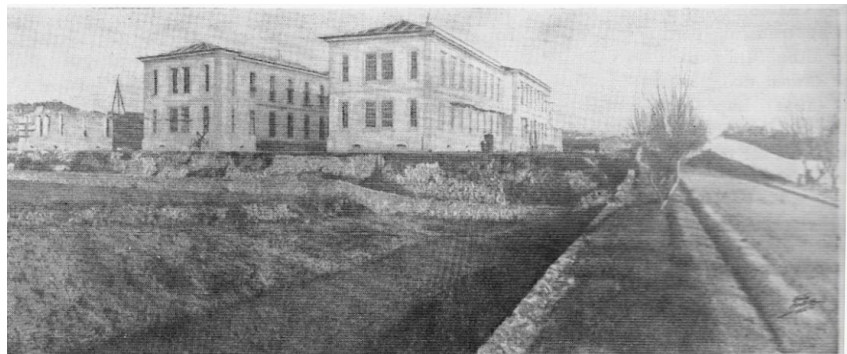
O edifício inacabado do Hospital Militar D. Pedro V, hoje denominado Hospital Regional N.º 1, segundo uma curiosa fotografia de 1865 em que se observa, à direita, o antigo sítio das Valas, antes da abertura da actual Rua da Boavista.
